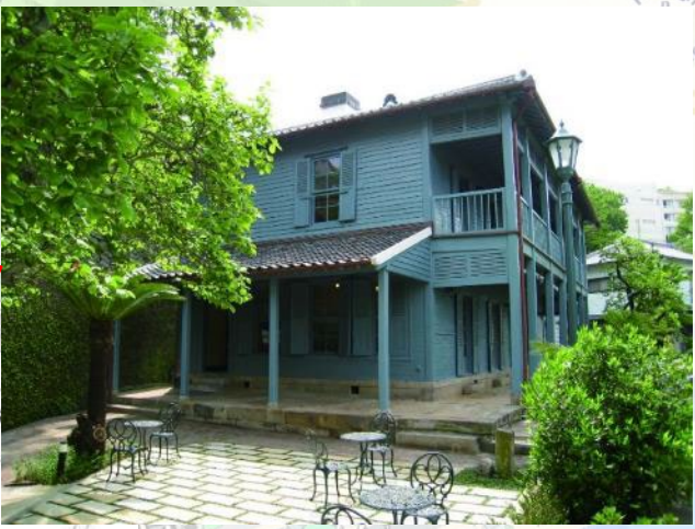
東山手甲十三番館 (伝統的建造物)
