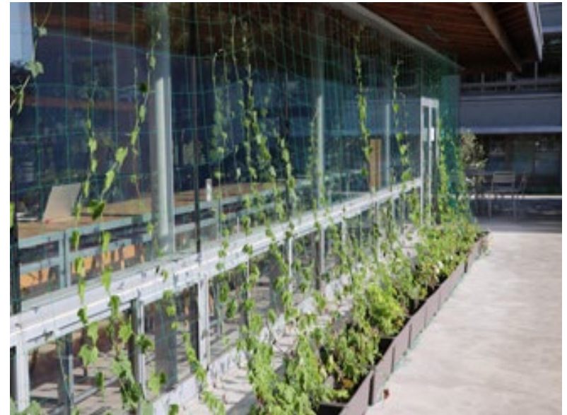
学生食堂の窓に設置したグリーンカーテン
